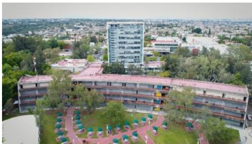
Figura 4. Vista aérea aulas ala norte después de la intervención (Coordinación de Servicios Generales del CUAAD).
