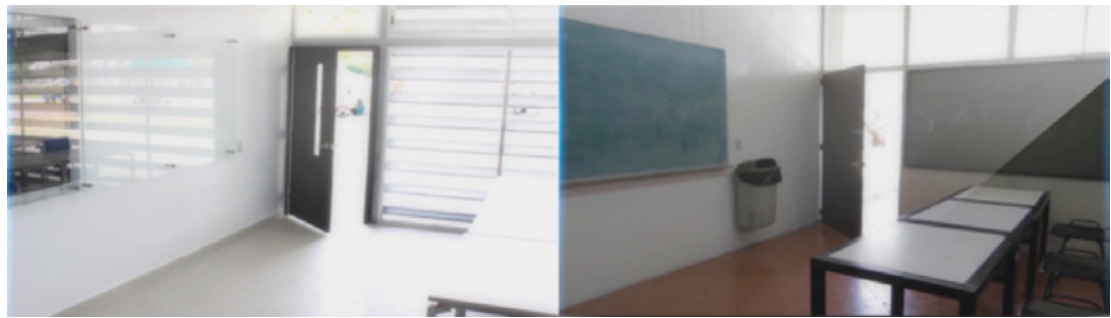
Figura 8. (Izq.) Vista de aula modelo remodelada (frente derecho) instalación de puerta con mirilla y cancelería de aluminio, así como de cristales templados y película esmerilada parasol. (Der.) Aula modelo antes de la intervención (Coordinación de Servicios Generales del CUAAD).
