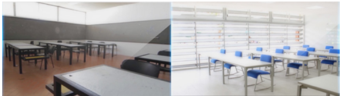
Figura 10. (Izq.) Aula antes de la remodelación. (Der.) Vista posterior izquierda de aula remodelada, sobre la fachada se encuentran instalados los parasoles conformados por celosías metálicas con encorves en las orillas (Coordinación de Servicios Generales del CUAAD).
