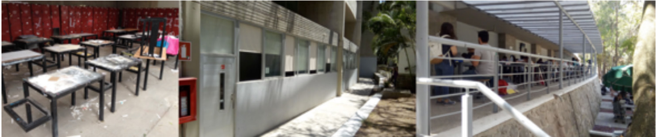
Figura 5. Vista del área de mesas de trabajo para alumnos (antes y después). Se aprecian las aulas remodeladas durante la intervención del periodo 2013-2018. Así mismo, se muestra el área que actualmente ocupan las mesas de trabajo (Coordinación de Servicios Generales del CUAAD).
