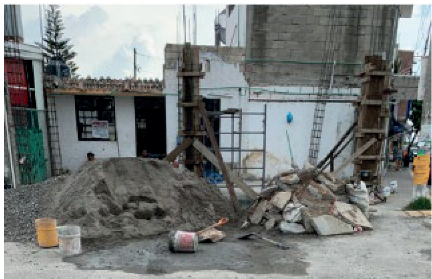
IMAGEN 4. REMODELACIÓN DE CASA HABITACIÓN A LOCAL COMERCIAL.
