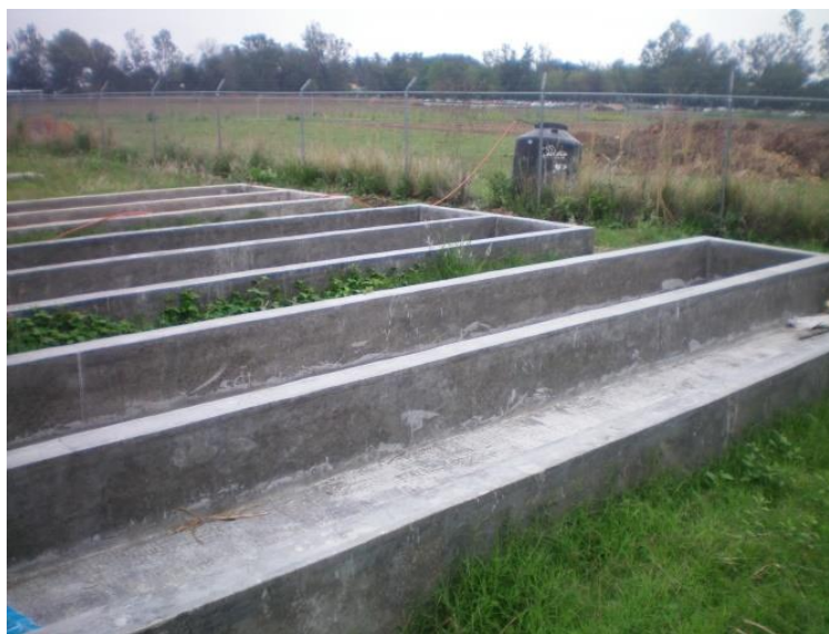
Figura 1. Cama de concreto en donde se ubican los biodigestores y el espacio para las lombrices.
