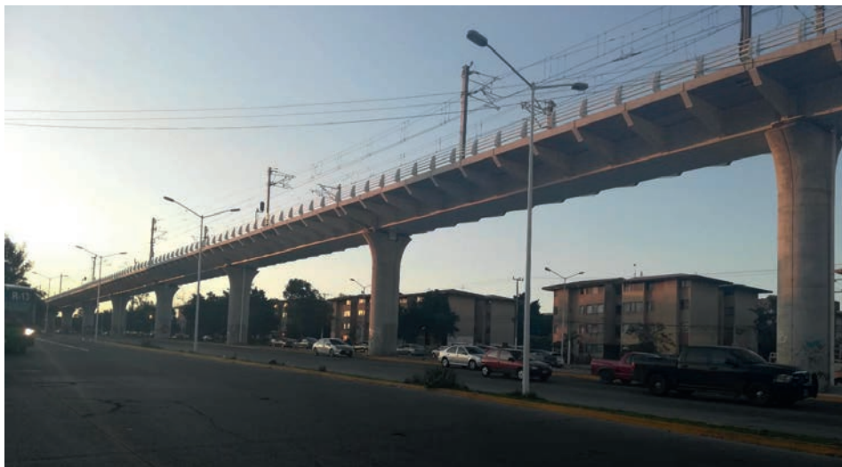
Figura 6. Tramo de la línea 3 del tren ligero por la avenida Juan Gil Preciado
