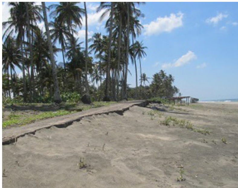
Figura 2. Erosión costera en Barra de Tupilco
