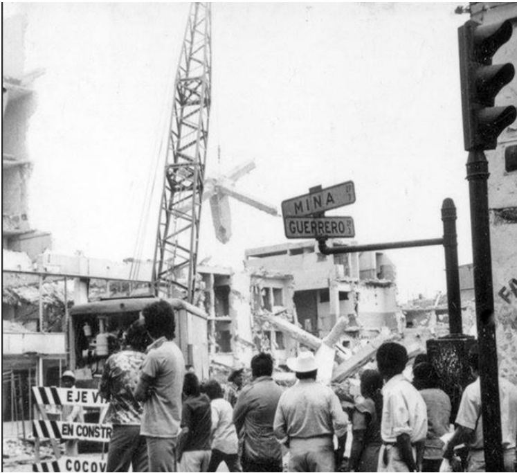
Figura 6. Demolición Mina Guerrero 1978. “Eje vial en construcción”
